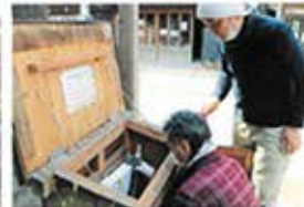
消火栓ホース取り換え作業
