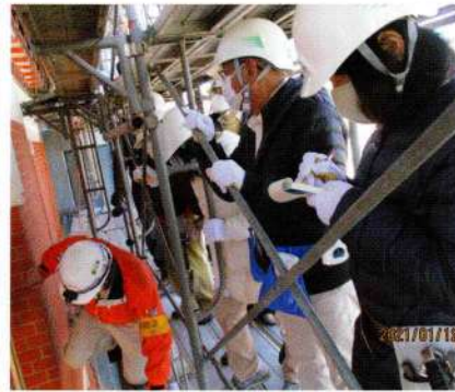
「三菱館」修復工事の2回目内覧会
