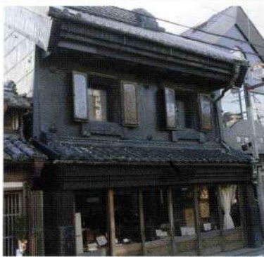
粋な看板の架かる重厚な中村乾物店
