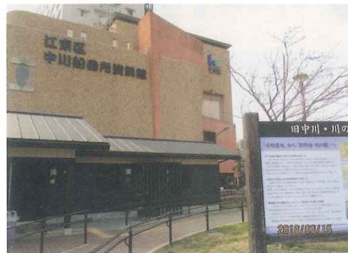
旧中川に面して建つ中川船番所資料館
