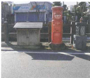
重伝建地区の中に溶け込んでいる消火栓。日頃から防火に心掛ける。
