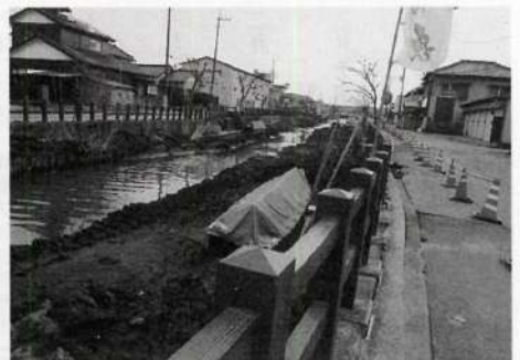
液状化で砂が噴出した小野川(初めは川一面を覆っていた)
