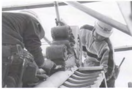
Installing the ogre tile / 鬼瓦の据え付け
