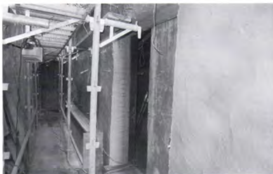
Entrance repairs / 入口部修理
