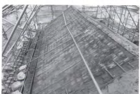
Roof substrate / 屋根下地
