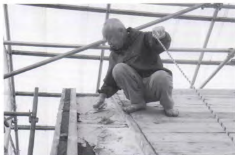
Roof substrate / 屋根下地
