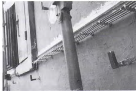
Substrate for flashing / 水切り下地
