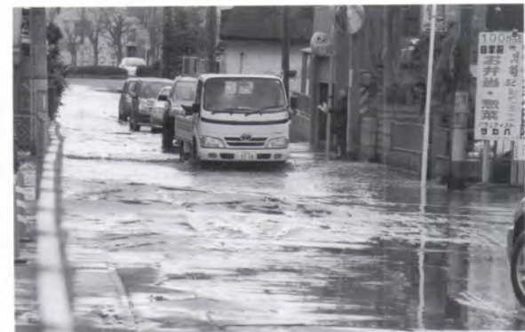
地震と液状化による被害
