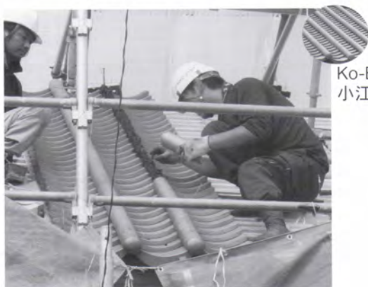
Reroofing with Ko-Edo tiles / 小江戸瓦葺き
