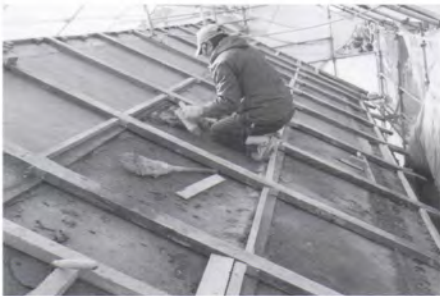
Roof substrate / 屋根下地
