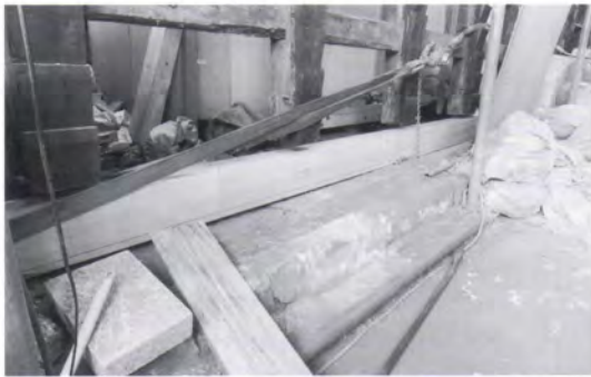
Foundation repairs / 土台修理
