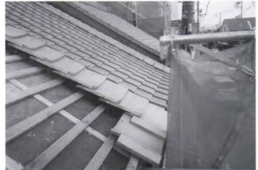
Roof repairs / 屋根修理
