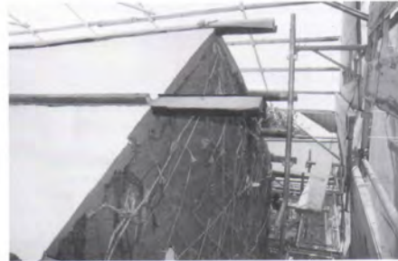
Gable detail / 破風部分
