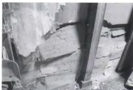
Storehouse lower wall / 土蔵腰巻部
