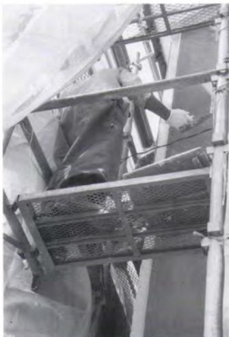
Exterior wall corner / 外壁隅
