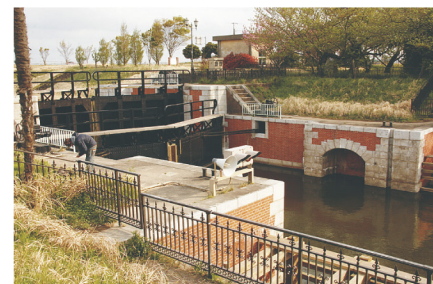
横利根閘門 複開式閘門 T3-10年
