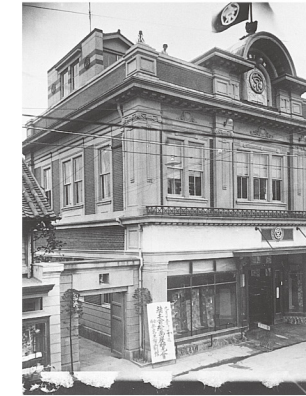
奈良屋呉服店 T6年 合資会社清水組施工
